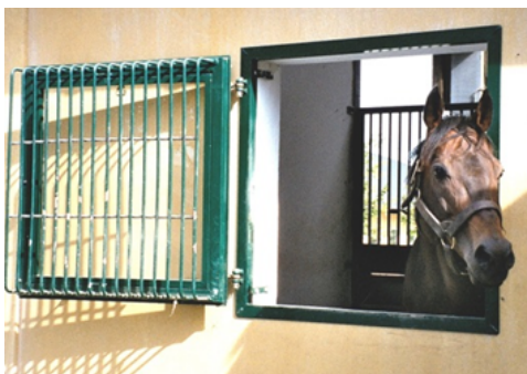
Abb. 11 Fenster mit Gitter zum Schutz vor Glasbruch.
